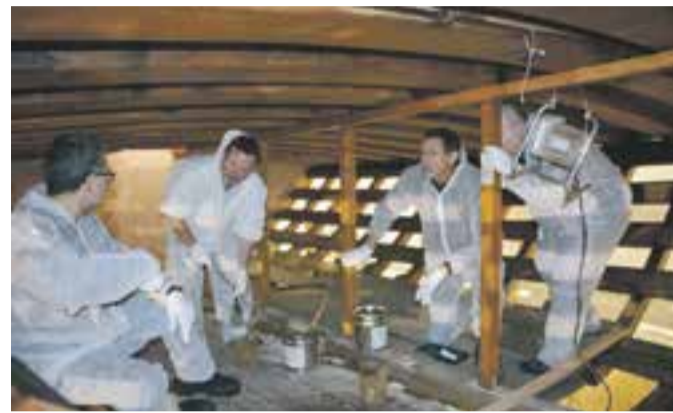
Les bénévoles, une aide précieuse sur le chantier.
